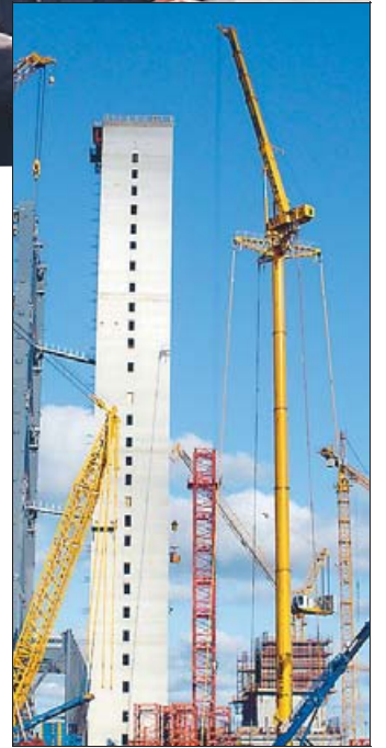
sante Kran-Parade auf dem Test- und Ausstellungsgelände am Deich streckt sich dann ein weiterer Gigant in den Himmel – fast 135 Meter hoch.
